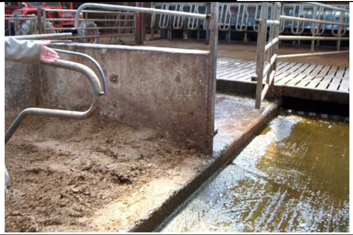
Vue d'une logette et du couloir raclé
