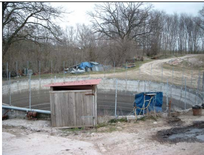
Fosse de stockage des effluents
