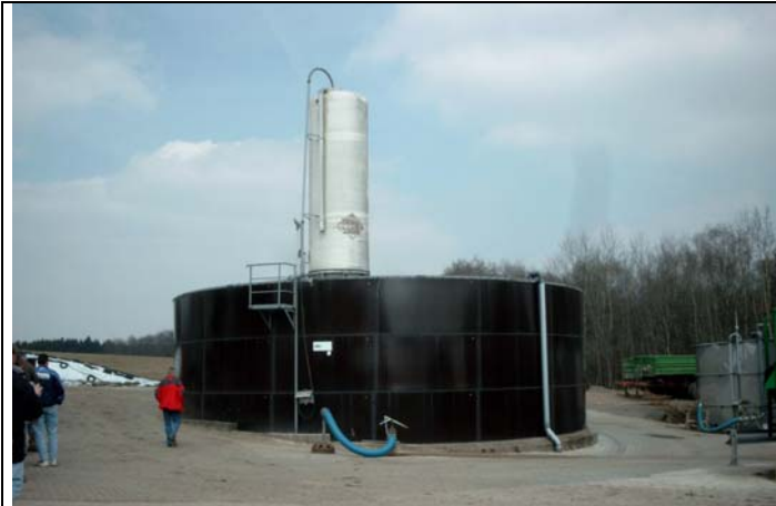
1ere cuve à effluent (existant avant le digesteur)
